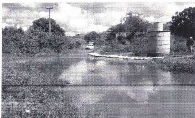
Foto 02 – Vista de margem esquerda observada nas proximidades de estaca 04
