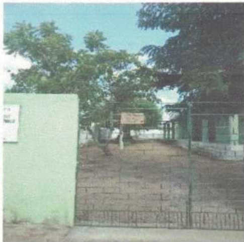
4 - CRECHE DO TABULEIRO
